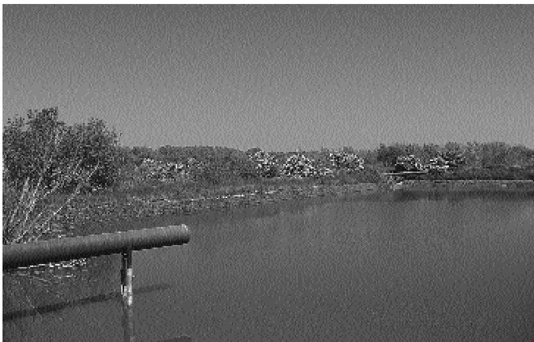
Photo 1 - Hollogne-sur-Geer, 2002 : vue d'un des bassins. - Hollogne-sur-Geer in 2002 : View of a basin.
