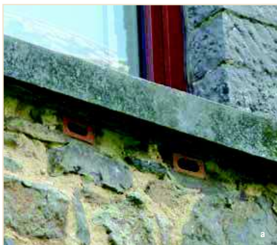
Photos 16a et b – Après avoir appris que la rénovation de cet ancien presbytère avait supprimé des cavités de Martinets, le nouveau propriétaire a décidé de rétablir les trous colmatés. Conseillé par le GTM, il a retiré la nouvelle maçonnerie au burin puis réalisé un orifice esthétique et discret ! Learning that the renovation of this former rectory had suppressed cavities used by Common Swift, the new owner decided to restore the holes which had been blocked. Following the advice of the Swifts Working Group, he removed the new masonry by chisel, replacing it by discrete and aesthetically pleasing entry holes (© P. Verstraeten)
